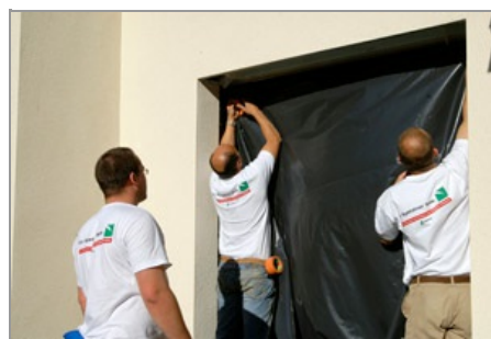
Mise en place de film opaque sur les ouvertures pour limiter la dessiccation de la chape
