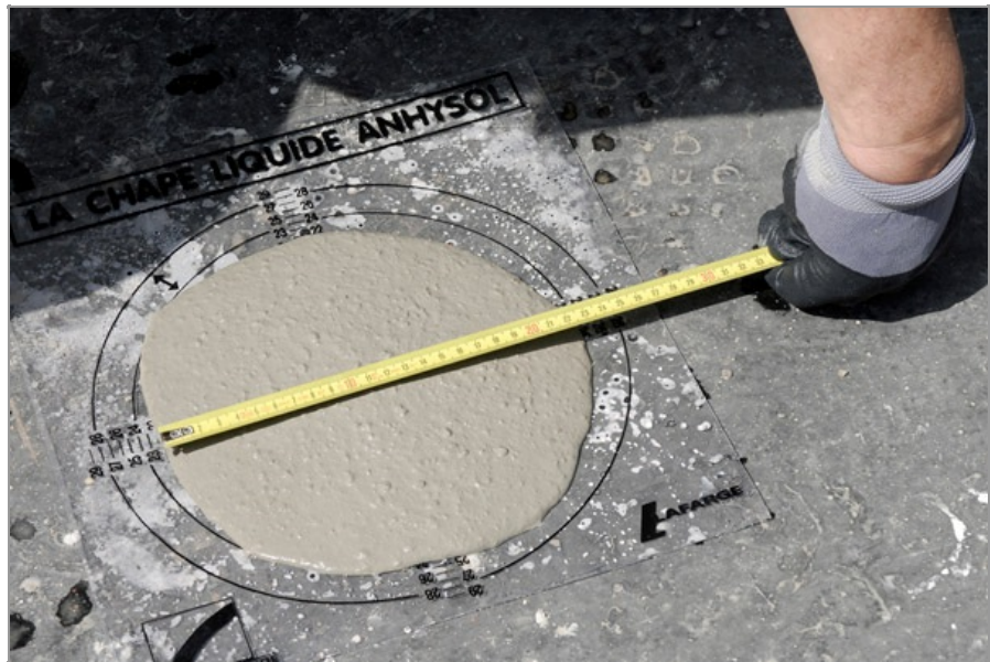
Mesure d'étalement à réception du mortier
