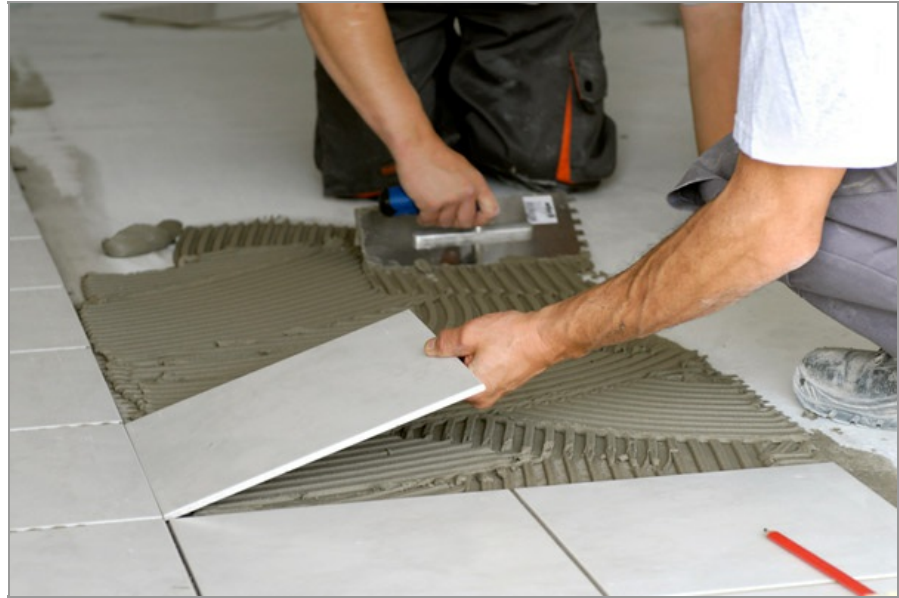
Pose de carrelage sur support chape fluide
