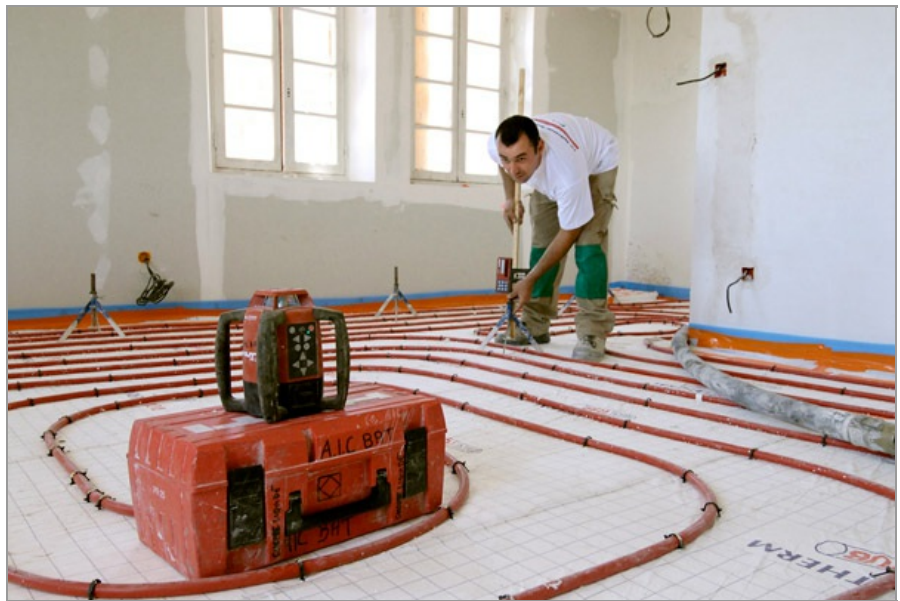
Mse en places des piges de niveau et cubage (calcul du volume nécessaire au chantier)
