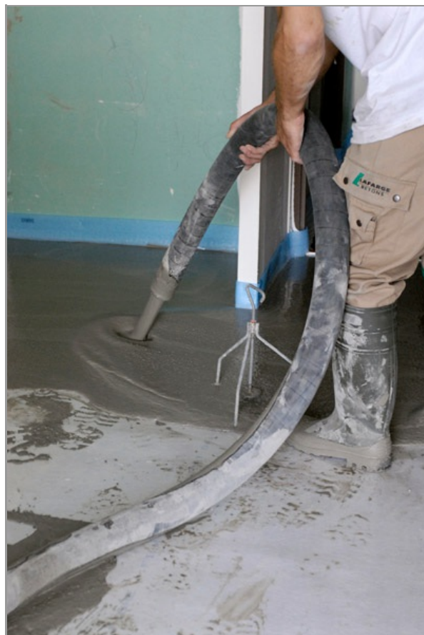
Coulage aisé de la chape fluide en position haute
