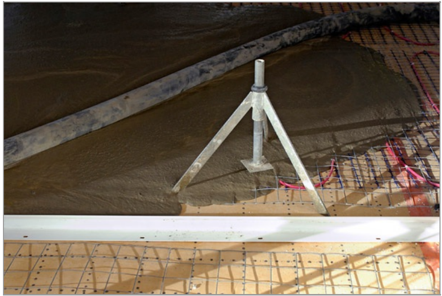
Joint de fractionnement plastique avant coulage de la chape aux passages de portes
