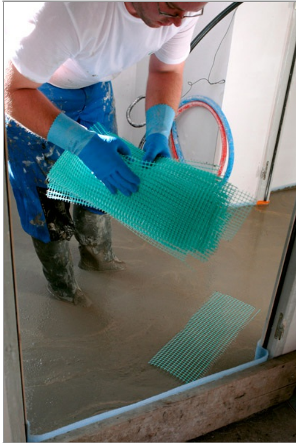
Mise en place de panneaux en fibres de verre aux angles saillants
